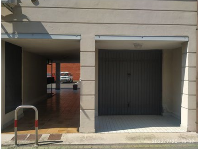
Foto 9: ingresso garage e portico esclusivo
