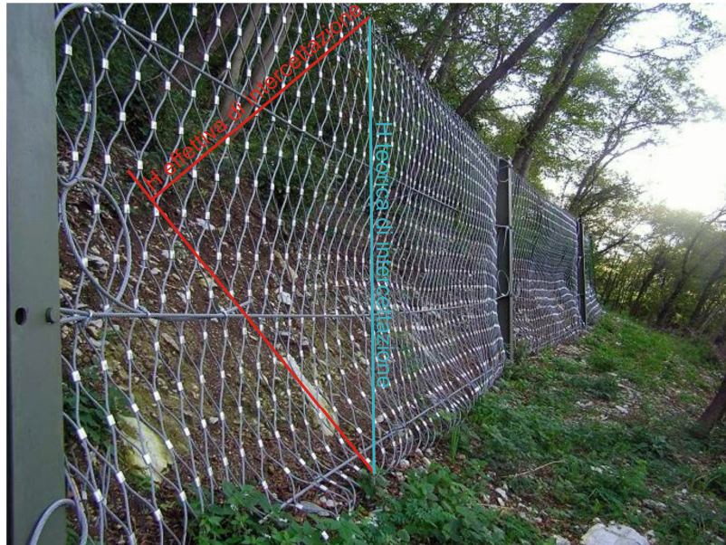
Fotografia 5 – Valutazione dell'altezza effettiva di intercettazione confrontata con quella teoricamente disponibile (2.5 m).
