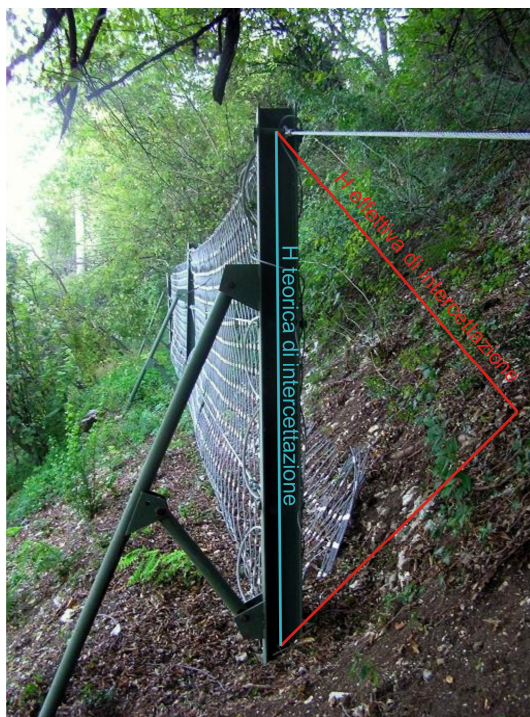
Fotografia 4 – Valutazione dell'altezza effettiva di intercettazione confrontata con quella teoricamente disponibile (2.5 m).
