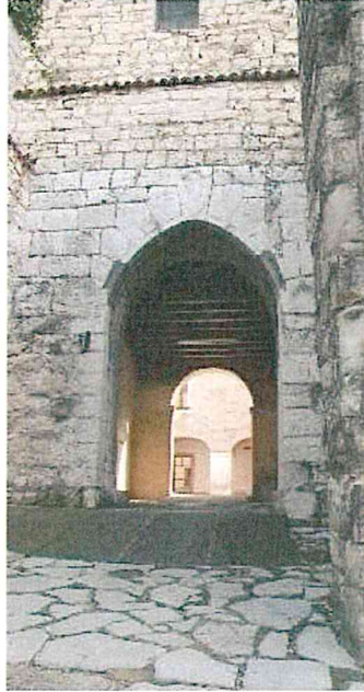
L'INGRESSO AL CASTELLO DALLA RAMPA CAPPUCCINI
