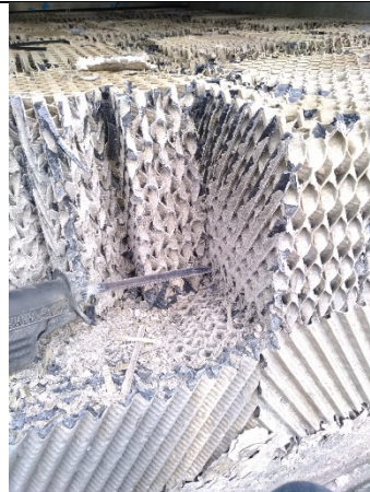
Figura 9: Interventi di demolizione
