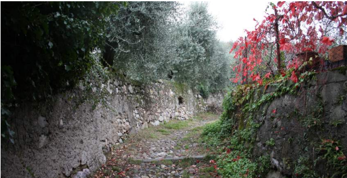
fotografia n.8: vista del muro di contenimento in pietra che costeggia il lato ovest dell'area
