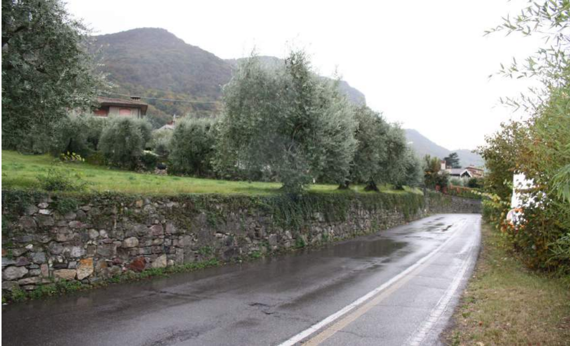
fotografia n.5: il muro di contenimento in pietra nella parte soggetta a vincolo paesaggistico
