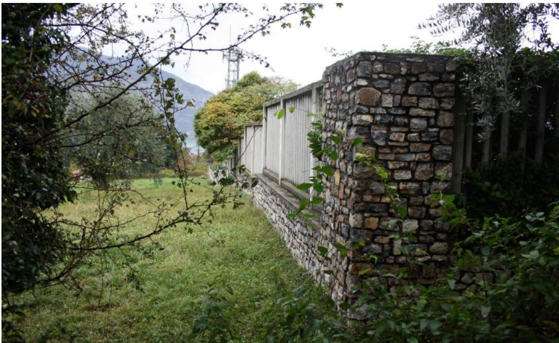
fotografia n.16: il muro di confine della centrale elettrica visto da sud
