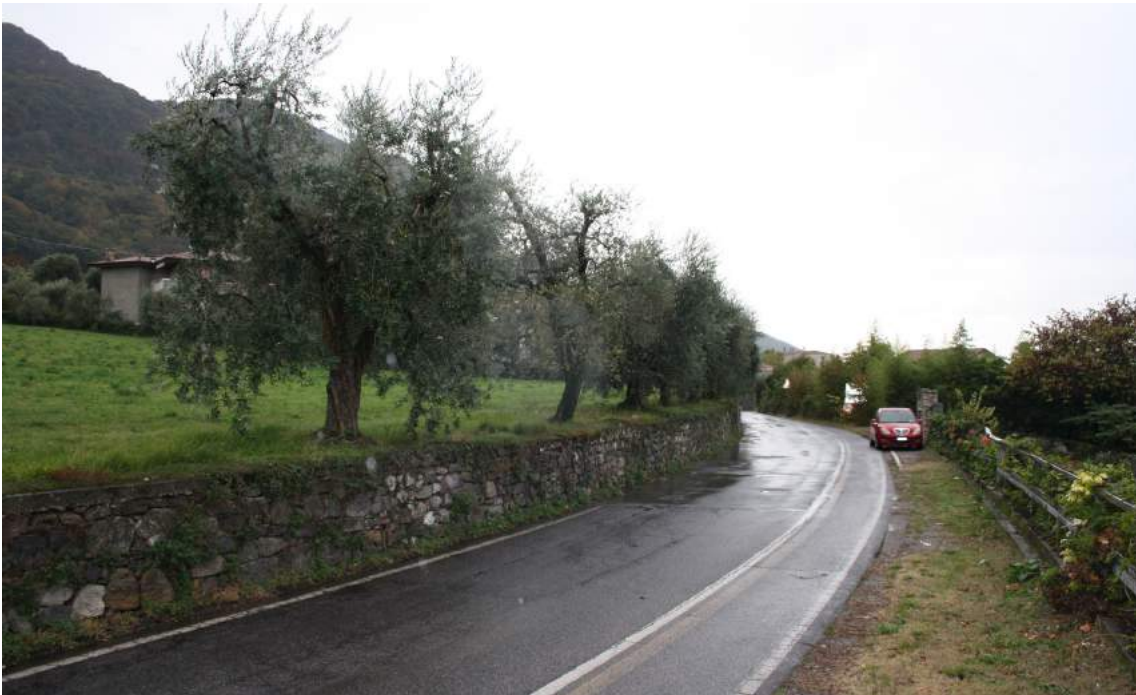
fotografia n.4: via Bonomelli. In primo piano gli ulivi da reimpiantare dopo l'intervento
