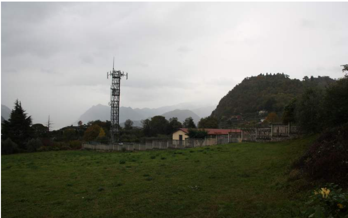
fotografia n.12: vista della centrale elettrica dell'ENEL
