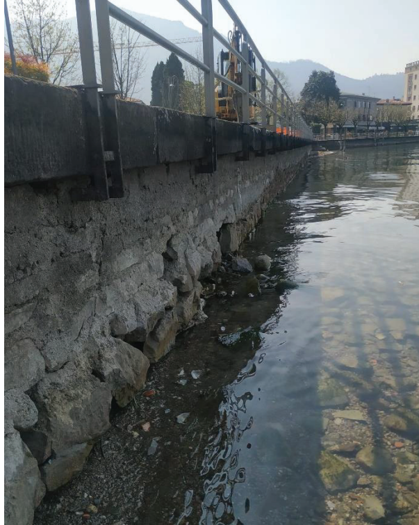
Figura 2 – Stato del muro in pietra
