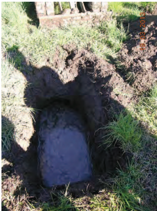
Foto 2. Scavo esplorativo S2
